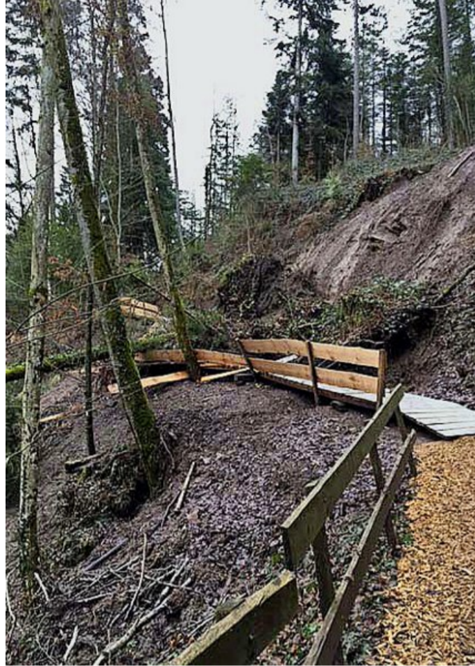
L'éboulement a arraché un ponton en bois installé en été. DR
